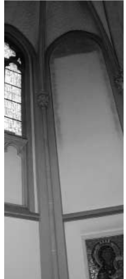
Von innen wurde Rigips davormontiert.
