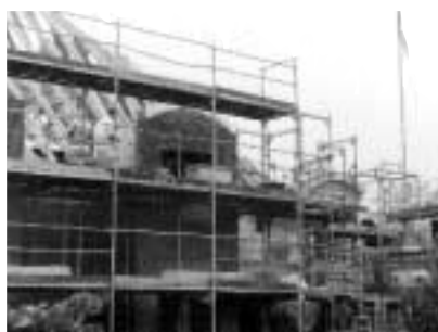
Täglich wächst der Neubau für das St. Elisabeth-Stift, das im Juli 1997 seinen Betrieb aufnimmt. Die Arbeiten liegen voll im Zeitplan.
