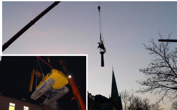
Zunächst wurde der Fürstbischof über das Dach des Krankenhauses an die Straße geholt. Dann wanderte auf gleichen Weg der Bagger in den Innenhof.
