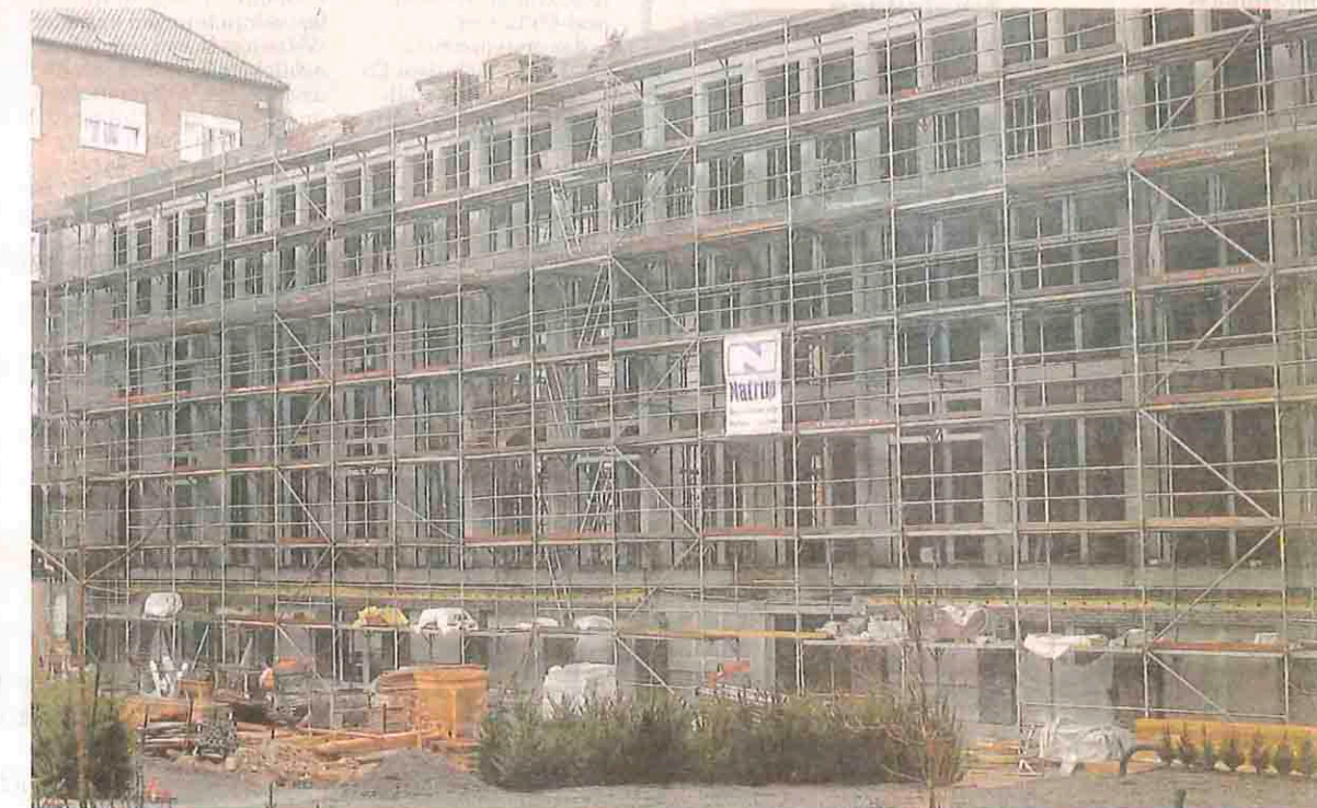
Der Rohbau im Innenhof des St.-Josef-Stifts ist fast fertig. Im kommenden Jahr soll er eingeweiht werden. Foto: Josef Thesing
