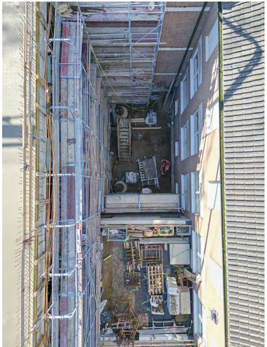
Das OP- und Funktionsgebäude an der Pennigstiege hat im Herbst seine Gesamthöhe erreicht. Im ersten Schritt werden in 2028 zwei OP-Säle in Betrieb genommen. Im Erdgeschoss wird die ASV Rheumatologie organisatorisch neu aufgestellt.
