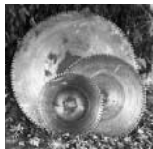
Riesige Sägeblätter waren erforderlich, um den teilweise 1 m dicken Beton zu zersägen.
