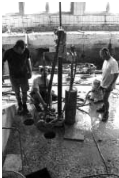
Mit Kernbohrungen wurde das Bodenfundament des Schwimmbeckens wie ein Schweizer Käse durchlöchert.
