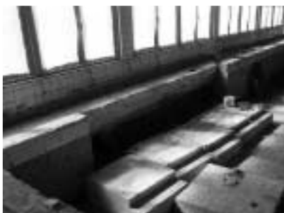
Unbeschreiblich laut waren die Steinsägen, mit denen diese großen Betonwürfel aus dem Schwimmbecken herausgetrennt wurden.
