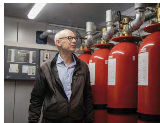
Die gasbasierte Löschanlage schützt die empfindliche IT-Technik im Brandfall vor Löschwasserschäden.
