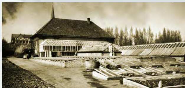
Mitte der 1920er Jahre wurde an das Gärtnerhaus für 20.000 Rentenmark ein erstes Treibhaus angebaut. Zusätzliche Mistbeete unter Glas sorgten dafür, dass schon früh im Jahr geerntet werden konnte.
