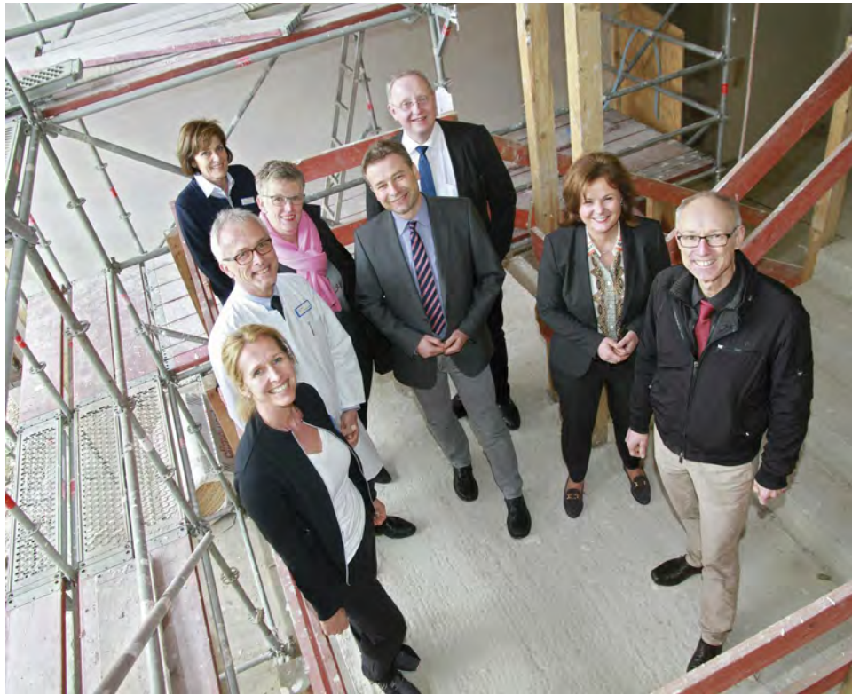
Die Steuerungsgruppe auf der Reha-Baustelle (v. l.): Dr. Heike Horst, Dr. Hartmut Bork, Roswitha Mechelk, Ursula Coerd-Binke, Ralf Heese, Detlef Roggenkemper, Rita Tönjann und Peter Kerkmann.
