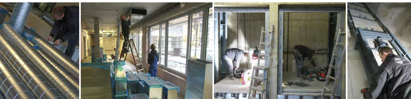
fang wird das frei tragende Treppenhaus. Auf Hochtouren werden die Lüftungsrohre installiert. Auch die Doppelaufzüge sind mittlerweile fertig montiert.
