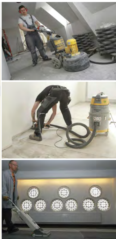
war das Abfräsen des alten Bodenuntergrunds.
