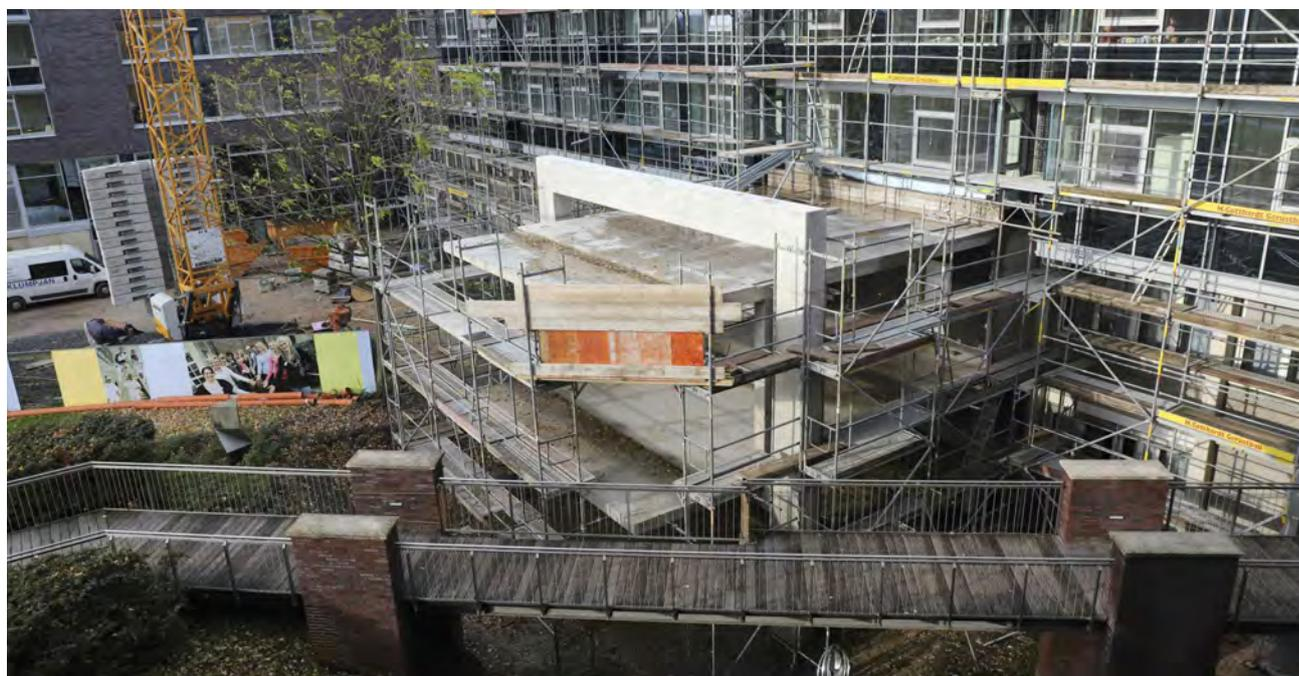
**Schon gut erkennbar ist die Kubatur des Südeingangs mit dem markanten Betonträger. Für die geplante Vollendung Ende Juni muss die jetzige Holzbrücke bereits im Frühjahr abgetragen werden. Als Ersatz wird es einen provisorischen Zugang unter dem Spithöver-Forum geben.**
