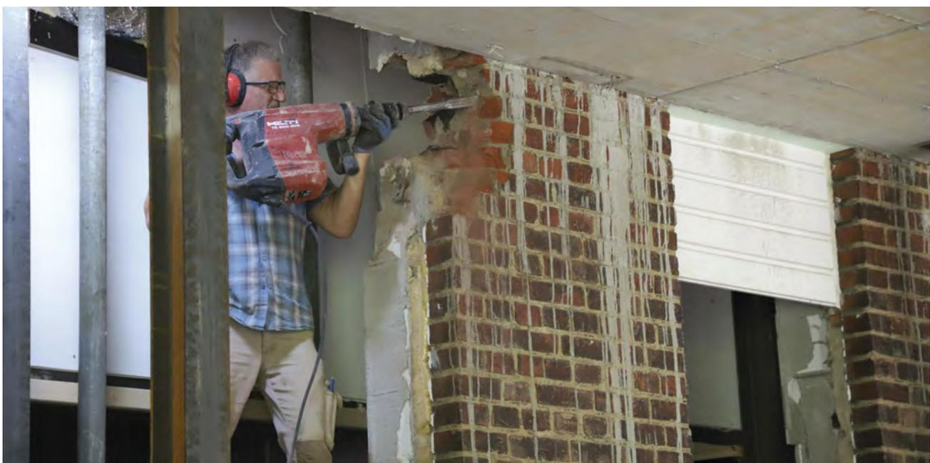
Mit dem Bohrhämmer wird die alte Außenwand der Küche Stück für Stück weggebrochen. Dafür müssen viele Eisen­träger gesetzt werden.
