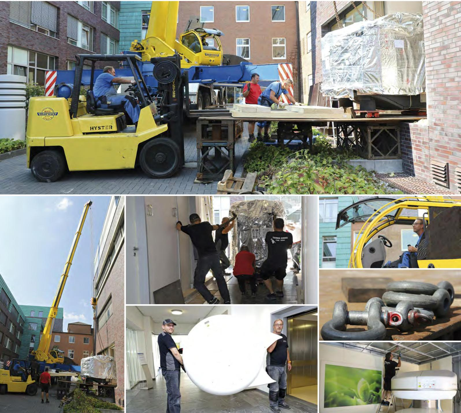
Operation MRT: Am langen Autokranausleger (Bild links) wurde der 14 Tonnen schwere Magnet für den neuen Magnetresonanztomographen an seinen Standort im St. Josef-Stift gehoben. Durch eine Öffnung in der Wand wurde der MRT mit Hilfe eines Gabelstaplers ins Gebäude geschoben (Bild oben) und auf Luftkissen und mit Muskeleinsatz an seinen Standort im Diagnostikzentrum gezogen (Bild in der Mitte). Wie ein Ufo (Bild, Mitte unten) muten Teile der Ummantlung an, die später am MRT montiert wurden.
