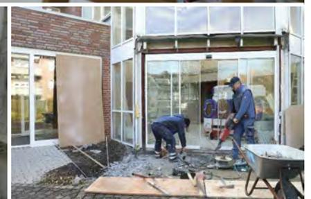
Der frühere Eingangsbereich des St. Josef-Hauses wird zum neuen Cafébereich umgebaut. Der alte Windfang wurde bereits zurückgebaut. Alte Tapetenmuster von 1983 kamen ebenso zutage wie die alte Telefonanlage.
