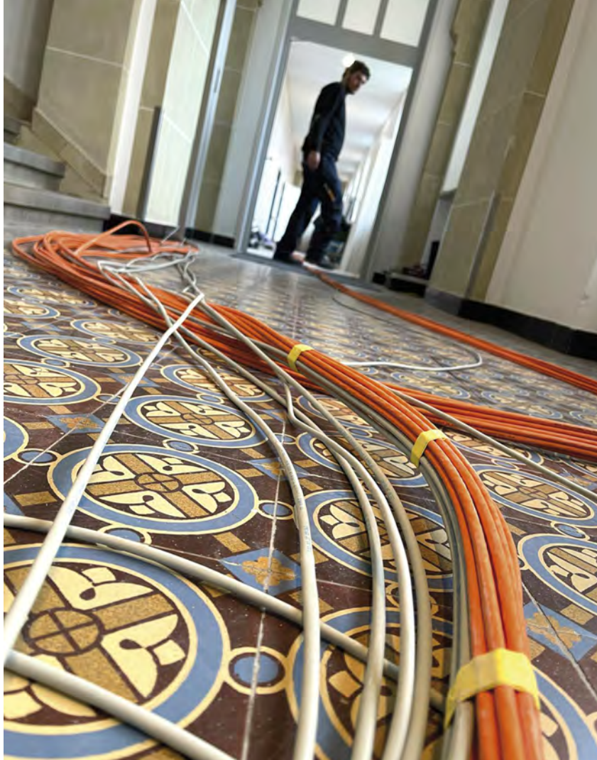
Viele Kabel wurden gezogen, damit das Patientenmanagement in seinem Backoffice mit moderner Kommunikations- und Internetinfrastruktur arbeiten kann.
