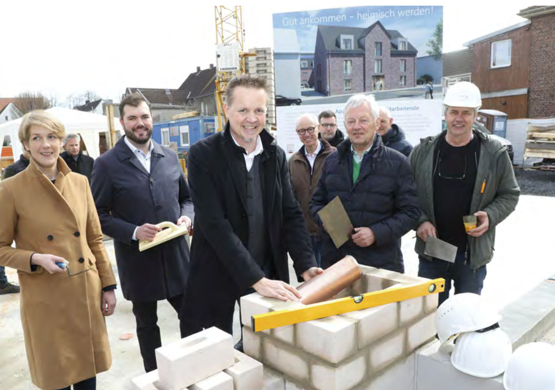
Am 22. März 2023 wurde der Grundstein für das neue Apartmenthaus des St. Josef-Stifts an der Südstraße 19 gelegt. Geschäftsführer Dr. Ansgar Klemann legte die Zeitkapsel mit aktuellen Zeitungen in den Grundstein. Beim Einmauern halfen (vorne v.l.) Bürgermeisterin Katrin Reuscher, Pflegedirektor Niklas Wiechert sowie Bauherr Kurt Gunnemann (r.), Kuratoriumsvorsitzender Werner Strotmeier (2.v.r.) und Technischer Leiter Peter Kerkmann (4.v.l.).
