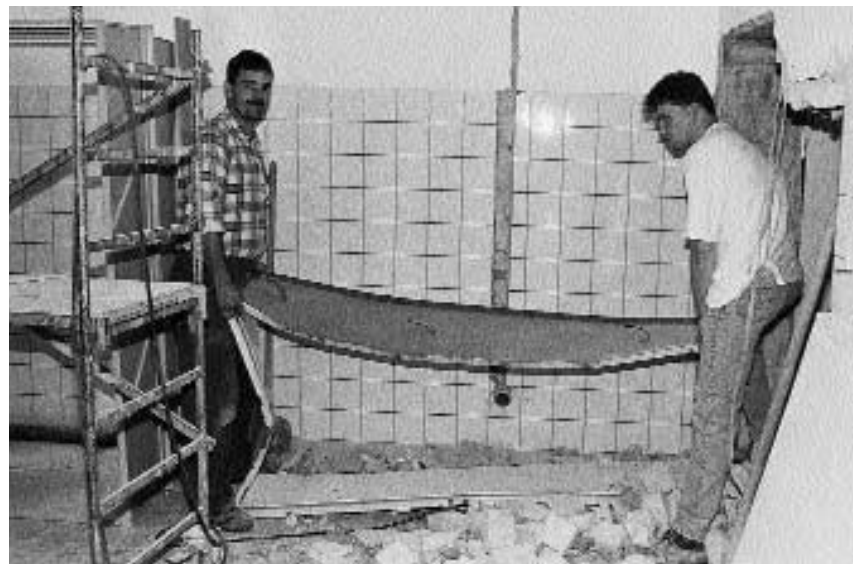
Mit viel Engagement und Können sind die Handwerker des St. Josef-Stiftes beim Umbau des Bettenhauses bei der Sache.
