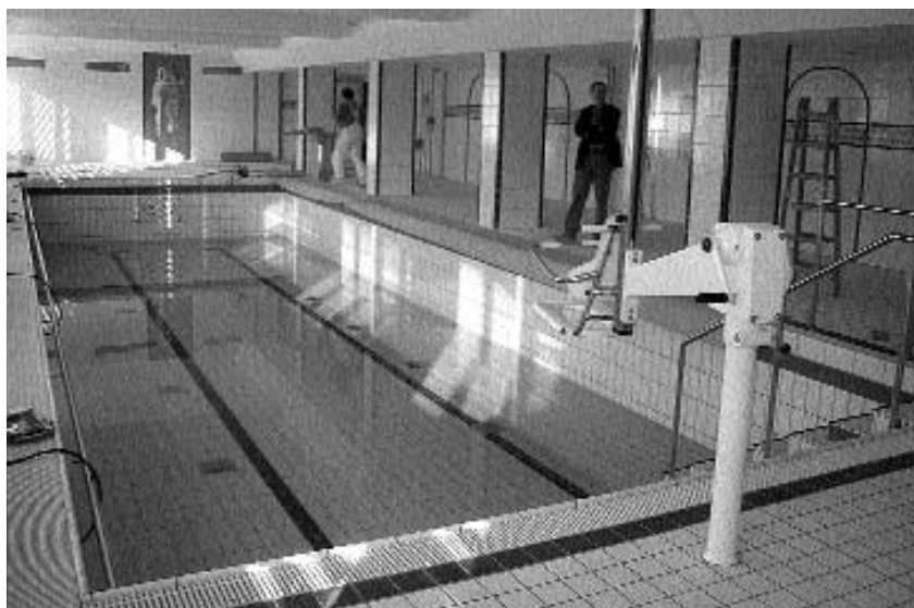
Die Modernisierung des Bewegungsbades ist abgeschlossen.
