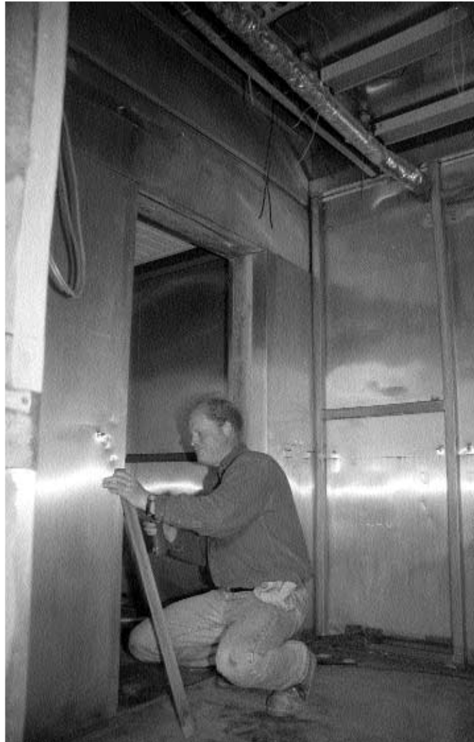
In mühsamer Feinarbeit demontieren Handwerker die stählernen Innenwände der alten Stickstoff-Kältekammer im St. Josef-Stift.
