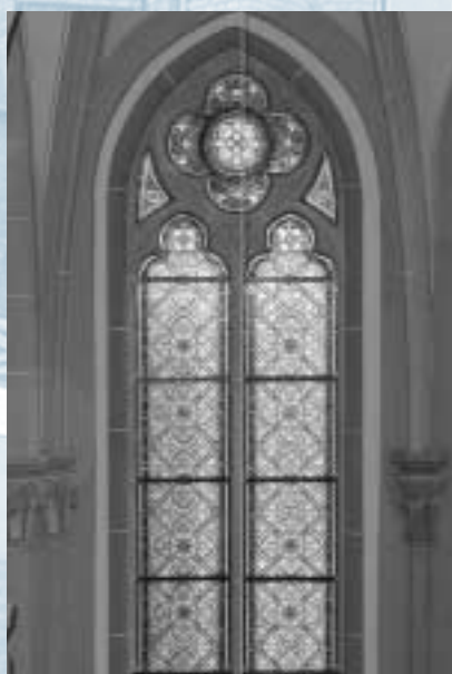
Erstrahlen in neuem Glanz: die Fenster der Kapelle
