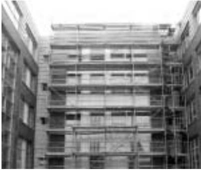
Mit dem schrittweisen Abbau der Baugerüste wird das äußere Erscheinungsbild des Parkflügels immer besser erkennbar.
