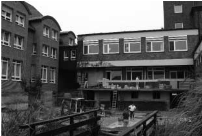
Im September liefen die Bauarbeiten für die neue Zufahrt zum Wirtschaftshof auf Hochtouren.
