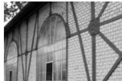
Das Stahlgerüst des denkmalgeschützten ehemaligen Kesselhauses wird im Sommer aufwändig saniert. Danach wird das schicke Gebäude in das geplante Konferenzzentrum mit drei Besprechungszimmern integriert.
