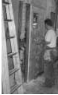
In Trockenbauweise entstanden schnell die neuen Wände für den neu gestalteten Bereich.
