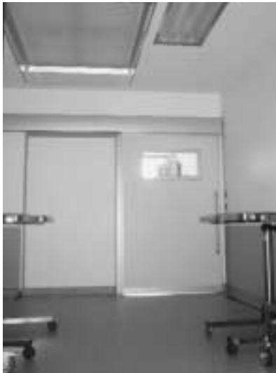
Zehn Tage später war derselbe Raum in einen Einleitungsraum mit moderner Klimadecke verwandelt.
