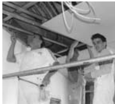
Mitte September begann der Umbau für das Physikalische Labor und den neuen Injektionsraum.
