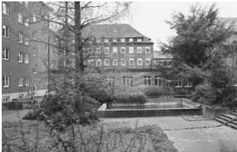
Der Innenhof wird völlig neu gestaltet. Prägender Baumbestand bleibt erhalten.
