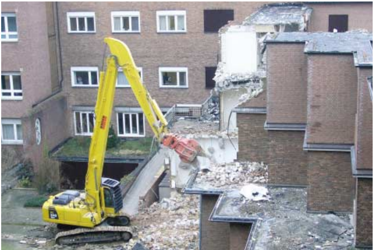
Im Januar begann der Abbruch des ehemaligen Zick-Zack-Gebäudes im Innenhof.
