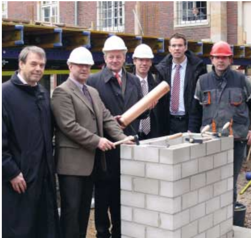
Architekt Michael Ludes, die Reha-Zentrum-Verantwortlichen Ingo Liebert, Werner Strotmeier, Christoph Wolters und Hartmut Hagmann sowie Polier Klaus Specker (v.l.) feiern die Grundsteinlegung.
