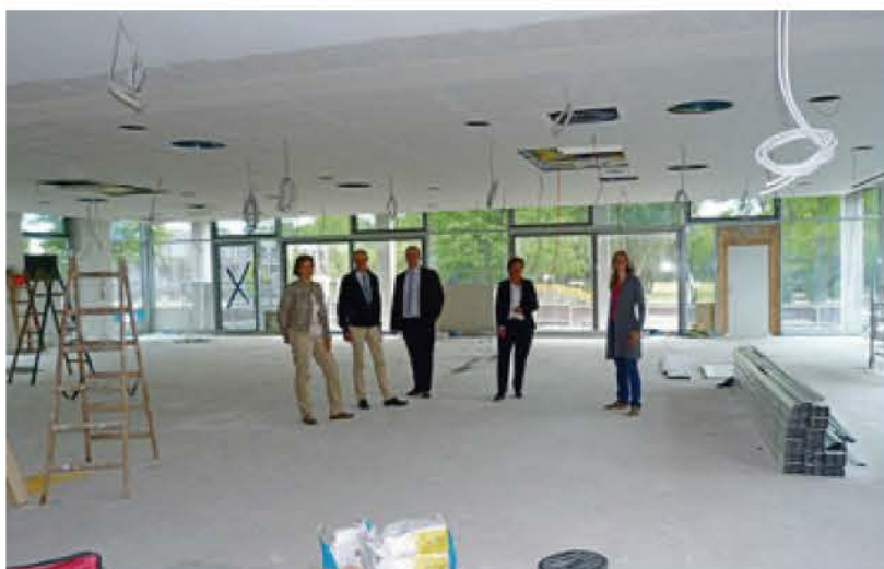
Erdgeschoss: Noch hängen die Kabel von der Decke, aber im August ist auch die Mitarbeitercafeteria fertig, die zugleich zentraler Veranstaltungsraum ist.
