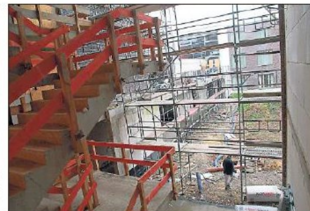
Ein Blickfang soll demnächst das freitragende Treppenhaus werden. Das Bild zeigt den Übergang zum Bestandsgebäude.
